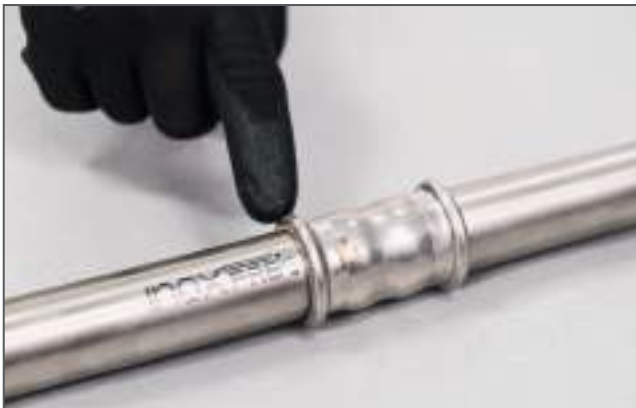
Controllo della pressatura / Checking the press connection
